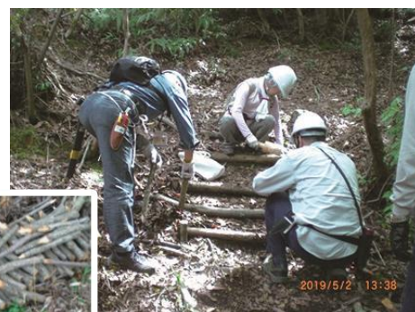
階段の修理作業
