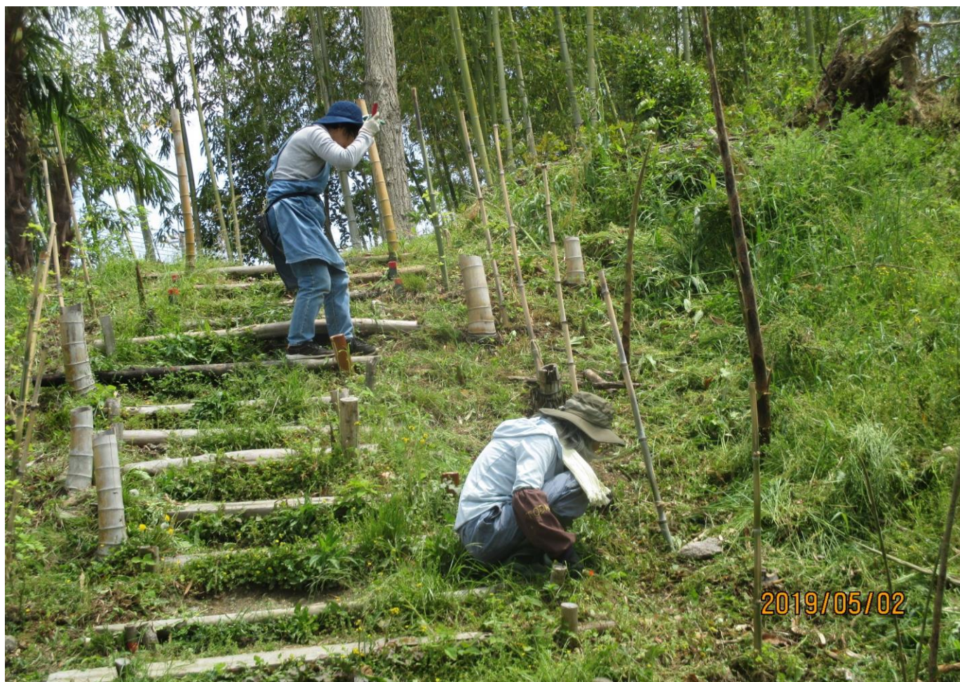
<大通りからの入り口階段の整備>
